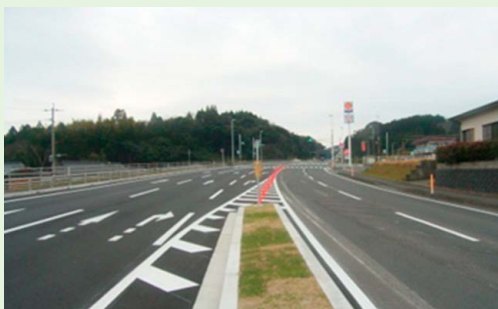
鹿児島3号 隈之城地区舗装工事
