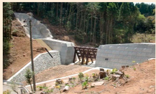
火山砂防工事(黒武者川工区)
