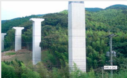
道路改築工事(泊野道路 18-2)
