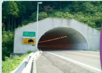
道路改築工事 (工事国債永野トンネル) 久保工務店・田島JV
