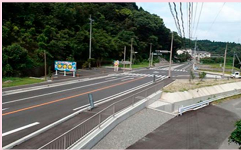
鹿児島3号土橋入口交差点整備工事
