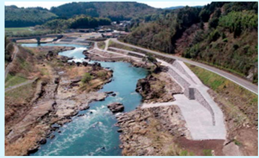
菱刈出張所管内環境整備工事
