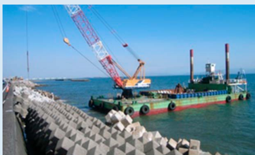
国道226号前之浜地区外防災工事
