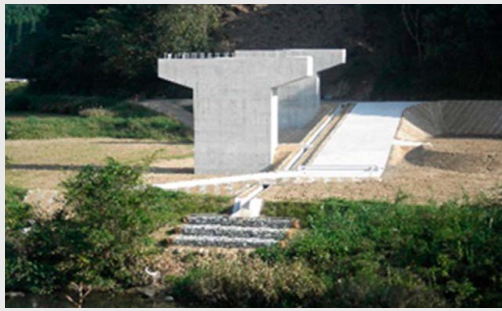
道路改築工事(広瀬道路 26-3)
