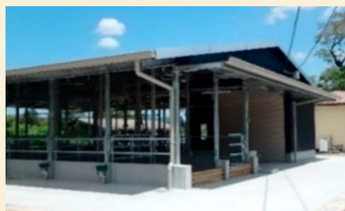
薩摩中央高校牛舎改築工事(建築) 鹿児島県
