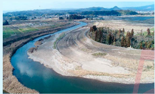
羽月川下流掘削工事
