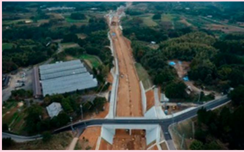
鹿児島3号赤瀬川地区改良工事
