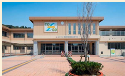
東郷学園義務教育学校管理 中学校棟新築(建築)工事 薩摩川内市 植村・田島・山之内JV
