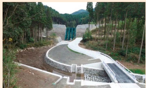
火山砂防工事(大馬越川(3)工区)
